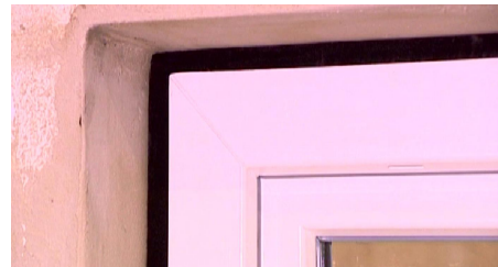
Mit der zeitsparend ausgeführten Schlaufenbildung wurden die Eckbereiche sicher abgedichtet.
